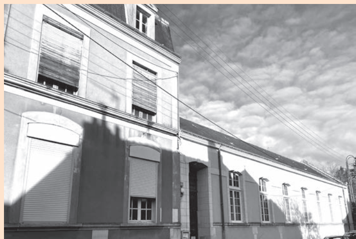
L'actuel bâtiment de l'école rue Haute-de-Reclée
