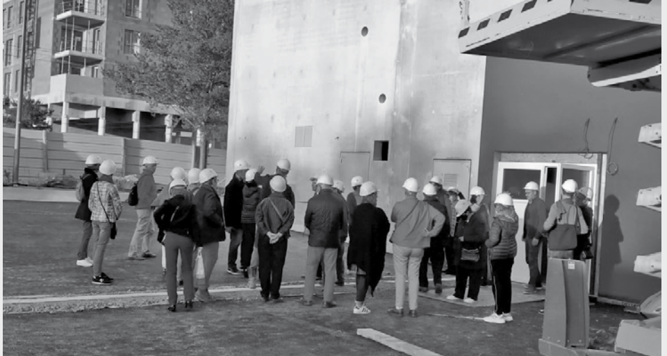
L'entrée de la future Maison de quartier en construction
